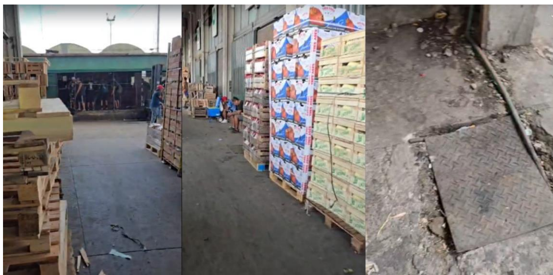
Salida de puesto a dársena – Dársena - Rejillas de la dársena.
